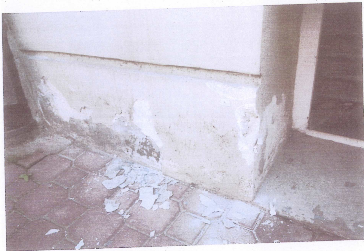
Fot. 3 Fragment niszczonego cokołu. Zaznaczono miejsce pobrania próbki H.
