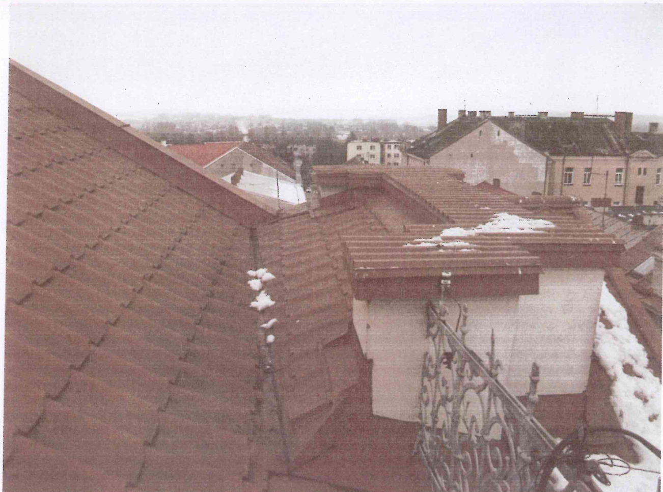
Foto. 6. Dach – elementy instalacji odgromowej.
